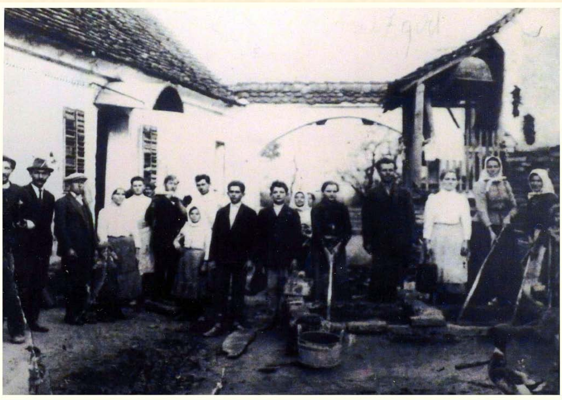
Na slici: Adamov grunt 1927. godine - zidarski radovi na žitnici
